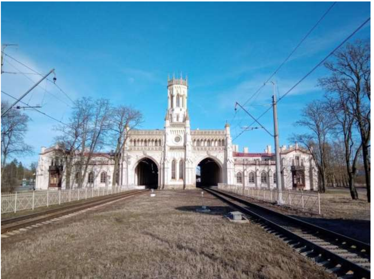
Рис. 57. Вокзал станции Новый Петергоф – единственный в России железнодорожный вокзал, построенный в готическом стиле (ныне полузаброшен) © Фото: В.Л. Мартынов, И.Е. Сазонова, 2020
